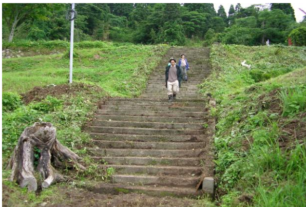
～草刈整備後の学校正面石段～
